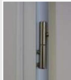
7 Die Position des Türblattes kann durch eindrehen, bzw. herausdrehen der Bänder geändert werden. Hierzu die Tür aushängen, 1-2 Umdrehungen das Band drehen und die Tür wieder einhängen.
