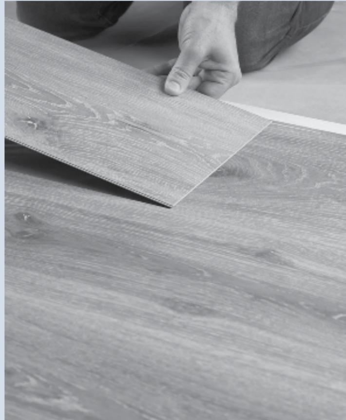
Vinyl mit SPC-Trägerplatte ist als Boden für den universellen Einsatz besonders dimensionsstabil. Seine Trägerplatte gleicht Unebenheiten perfekt aus. Renovierungen auf Fliesen können mit geringem Aufwand dem Wohnraum ein völlig neues Bild geben.
