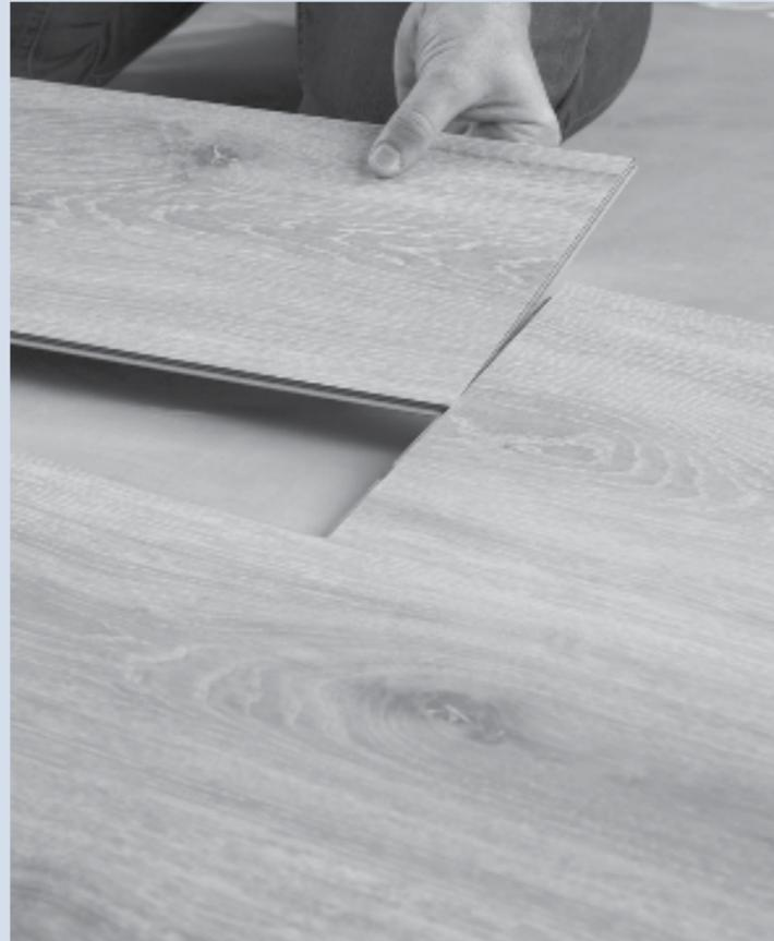
Vinyl mit HDF-Trägerplatte ist die perfekte Lösung bei der Gestaltung von allen Wohnräumen, in denen leichte Unebenheiten ausgeglichen werden müssen.
