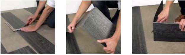
Die Elemente müssen spannungsarm und fugendicht in den Kleber eingelegt und innerhalb der vorgeschriebenen Zeit sorgfältig mit einer Lamellenwalze angedrückt werden. Bis zur vollen Durchhärtung des Klebers ist der Boden vor Temperaturänderungen und Sonneneinstrahlung zu schützen.
