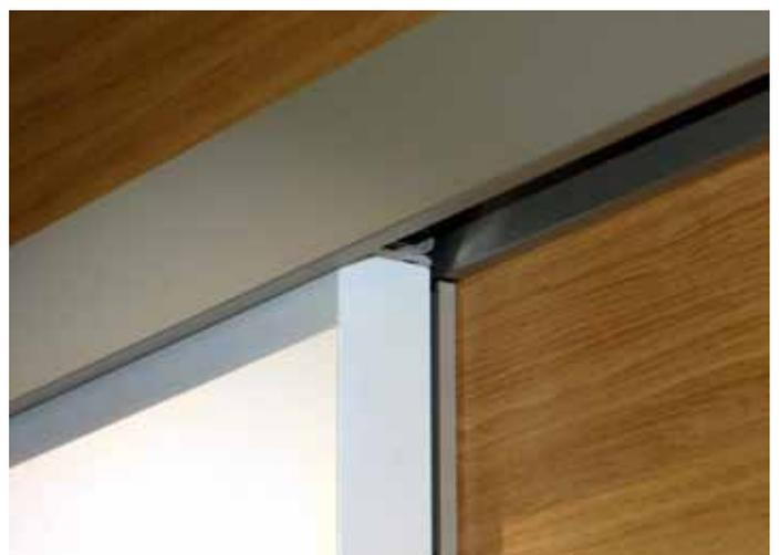
Der neue Schiebetürbeschlag Silence, der für vor der Wand laufende Schiebetüren geeignet ist, reduziert nicht nur Zugluft, Rauch und Geruch, sondern beugt auch Lärmeinflüssen vor. In Kombination mit einer Schallschutztür Typ42 SK II kann die neue Schiebetürlösung sogar einen Schalldämmwert von bis zu  $R_{w,R} = 32$  dB erzielen.
